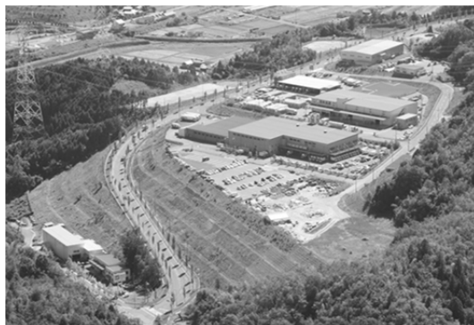
綾部市工業団地
