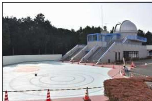
【3月13日(日) 工事完成直前の天文館の様子】
