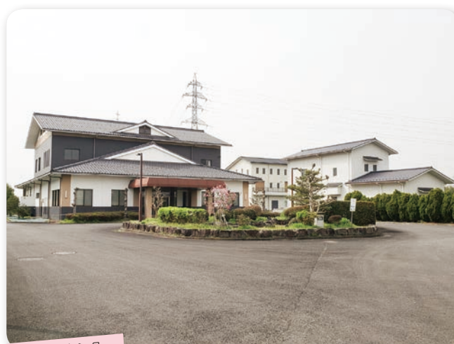
綾部浄化センター
